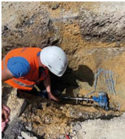
Branchement individuel sur la canalisation en cours de réalisation
