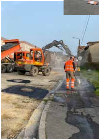
Réfection partielle de trottoirs et création de 2 passages piétons accessibles aux PMR
