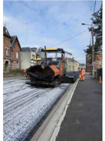
8 avril 2021 : pose de l'enrobé
