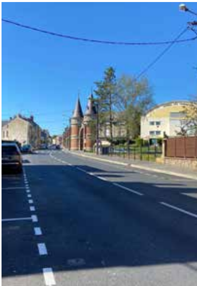
La rue Gambetta terminée
