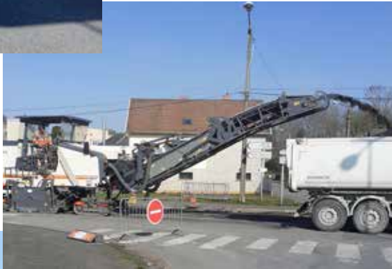
Grattage de l'enrobé existant
