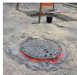
Remplacement des vannes hors service sur le réseau d'eau potable
